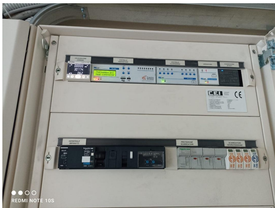
Figura 4 - Sezione dedicata al fotovoltaico esistente nel quadro generale
