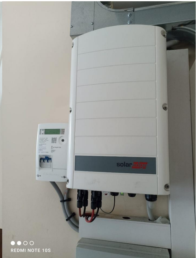
Figura 5 - Quadri di campo dell'impianto fotovoltaico esistente Figura 6 - Inverter da 16 kW dell'impianto fotovoltaico esistente
