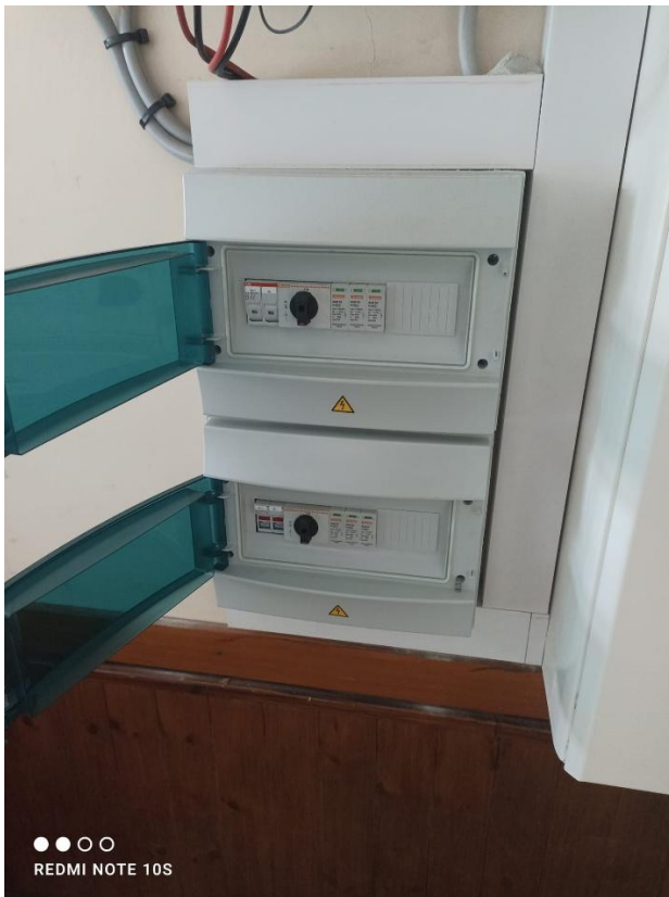
Figura 5 - Quadri di campo dell'impianto fotovoltaico esistente Figura 6 - Inverter da 16 kW dell'impianto fotovoltaico esistente
