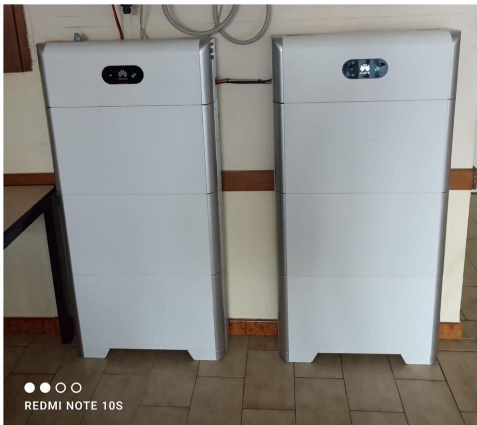
Figura 7 - Sistema di accumulo dell'impianto fotovoltaico esistente
